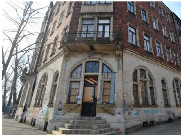
Nur notdürftig verbarrikadiert sind die beschädigten Fenster der „Praxis“ nach dem Anschlag. Ein Zug rechtsextremer Demonstranten hatte das Gebäude massiv angegriffen.
